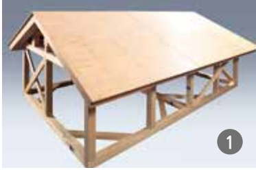
1 새 지붕을 이을 수 있는 상태로 산자를 조정합니다. 지붕마루부는 산자판을 잘라 개구부를 만듭니다.
