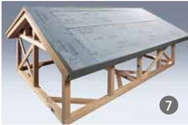
7 터프목 위에 보강 루핑을 바릅니다. 또한, 지붕마루 부분에 환기 지붕마루를 설치하기 위한 예비 홀을 뚫습니다.
