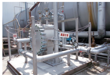
ACドレン熱回収システム
