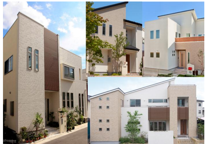
全体で3位となった「シンプルナチュラル」の外観スタイル
