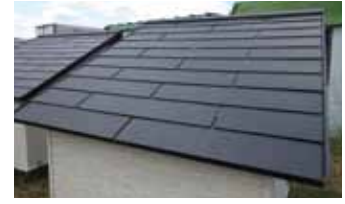
2016年8月測定データ 場所:滋賀県湖南市 屋根勾配:4寸 屋根面積:3.3m 2 断熱材なし 換気棟なし
