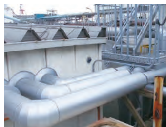
蒸気配管断熱強化 (堺工場)
