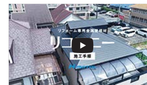
リコロニー施工手順
