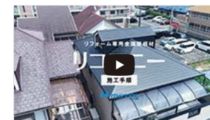
リコロニー施工手順
