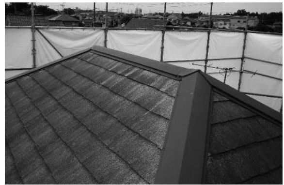
棟高までシートを設置
