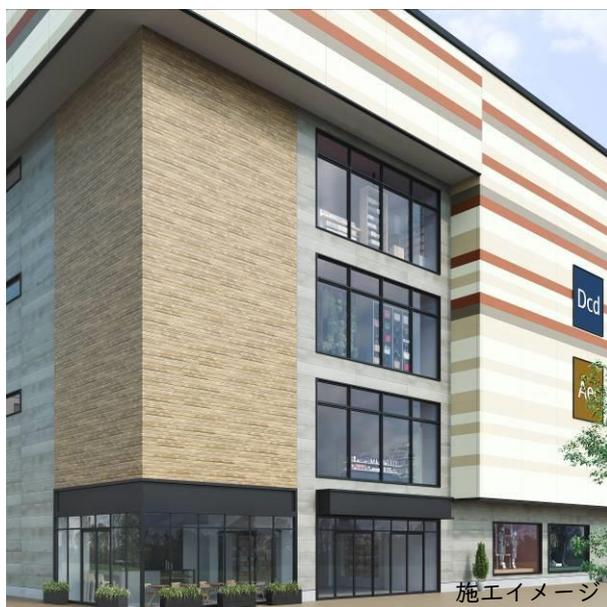
非住宅向け工法「フィルドラ」は、ダブルレイヤー(2層)仕様の工法です。工場内で胴縁用アンカーを埋め込んだALCパネルをベース板「フィルドラ・ベース」とし、窯業系サイディングをデザインパネル「フィルドラ・デザイン」として重ねることで、ALCパネル「シポレックス」の優れた耐火性・耐震性で建物を守る性能と、窯業系サイディングパネル「ケイミュー」の多彩なデザインや光触媒技術の相乗効果により、非住宅に今までない新しい意匠性を生み出します。また、長い年月を経ても高い防水性と建物の美しさと強さを保ち続けるため、再塗装や打診検査などのメンテナンスコストを低減し、建物の長寿命化に貢献いたします。将来的にはフィルドラ・デザインのための交換も可能な可変性も持ち合わせるため、デザインの一変も容易です。
