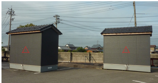
▲測定ポイント(西面を測定)
