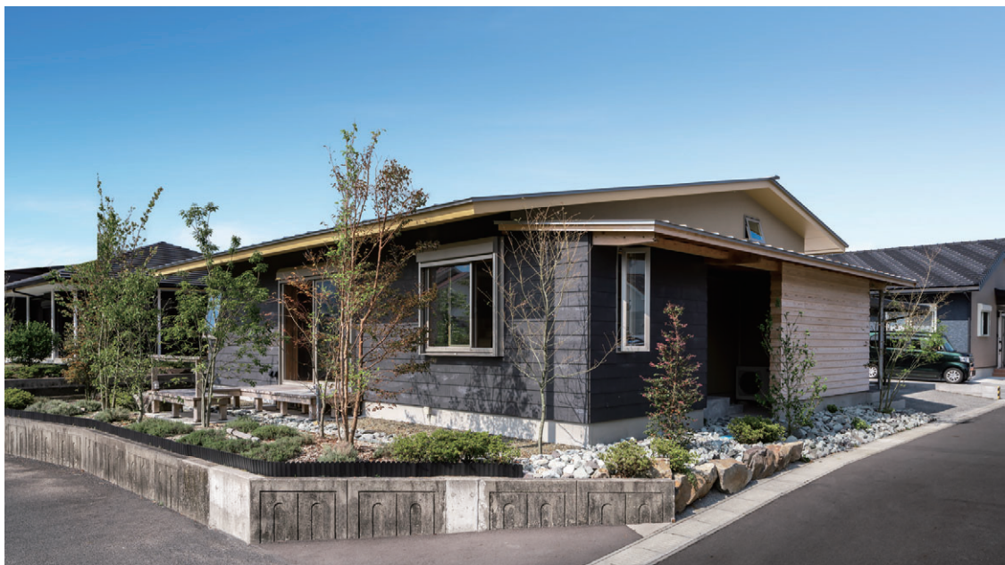
2020年の「KMEW DESIGN AWARD」で最優秀賞(竹原賞)を受賞した「喜入の家Ⅲ」(上)と、同じく2019年に同賞を受賞した「インターバルハウス」(右)。「喜入の家Ⅲ」の外壁は「カラーベスト」の技術を活用してできた「SOLIDO typeM_LAP」の鉄黒とスギの下見板張り。経年変化がもたらす美しさを表現できる。「インターバルハウス」では、外壁に木目調の窯業系サイディング「エクスレージ・親水 14 木目調」(ケイミュー)を採用。建物を包む豊かな植栽のキャンパスとして機能している
