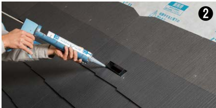
本体を加工し留付けます。すき間にはシーリングをします。
