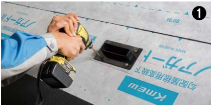
開口位置に防水テープおよび下部材を取付けます。
