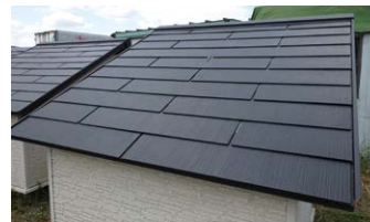
2016年8月測定データ 場所:滋賀県湖南市 屋根勾配:4寸 屋根面積:3.3m 2 断熱材なし 換気棟なし
