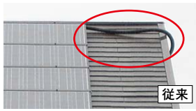
従来、配線ケーブルは軒天や表面から引込んでいたため屋根面に露出して見えます。
