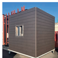
条件(ケイミュー社内検証) 施工面積: 約15m 2 (約4.5坪) 施工方法: 千鳥張り、釘4本留め 職方: 2名
