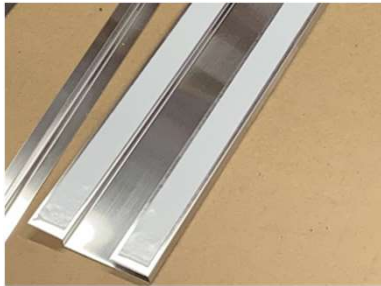
巾木に両面テープ貼付け
