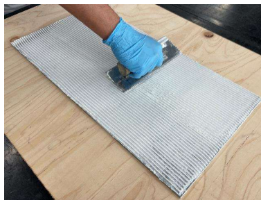
SOLIDO裏面への接着剤塗布 (くし目3mm)
