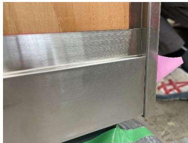
出隅および巾木の施工
