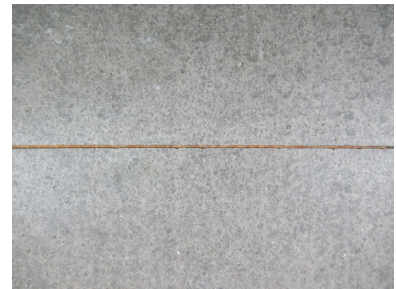
目地部の下処理を行わなかった場合 (写真は合板下地)
