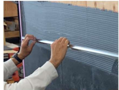
目地材の施工
