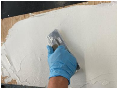
下地への接着剤塗布 (くし目3mm)
