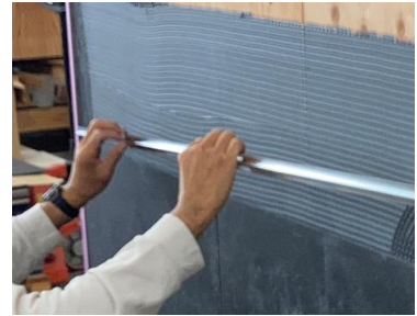
目地材の施工
