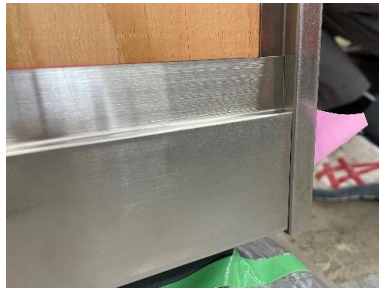
出隅および巾木の施工
