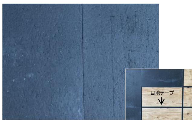
目地部の下処理を行った例 (写真は目地テープ)
