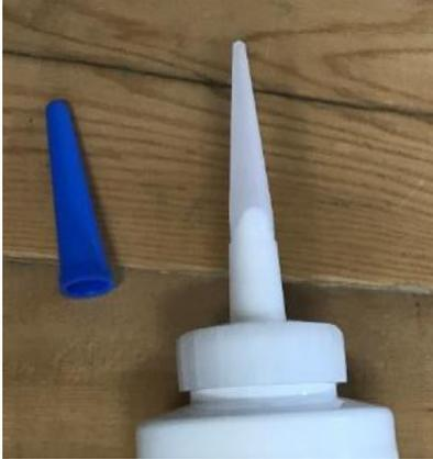
(2) ジョイントコークの先端を切断します。
