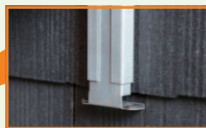
2 同様に下端部のフックで挟み、固定します。
