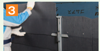
4 カラーベスト片側を支えることで釘打ちなどの施工がしやすくなります。
