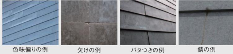
色味偏りの例 欠けの例 バタツキの例 錆の例
