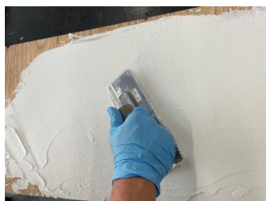
下地への接着剤塗布 (くし目3mm)
