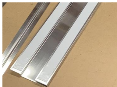
巾木に両面テープ貼付け
