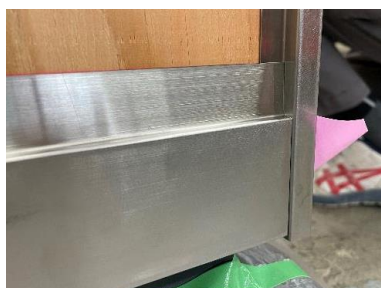
出隅および巾木の施工
