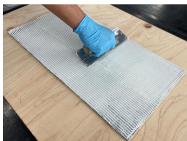
SOLIDO裏面への接着剤塗布 (くし目3mm)
