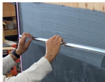
目地材の施工
